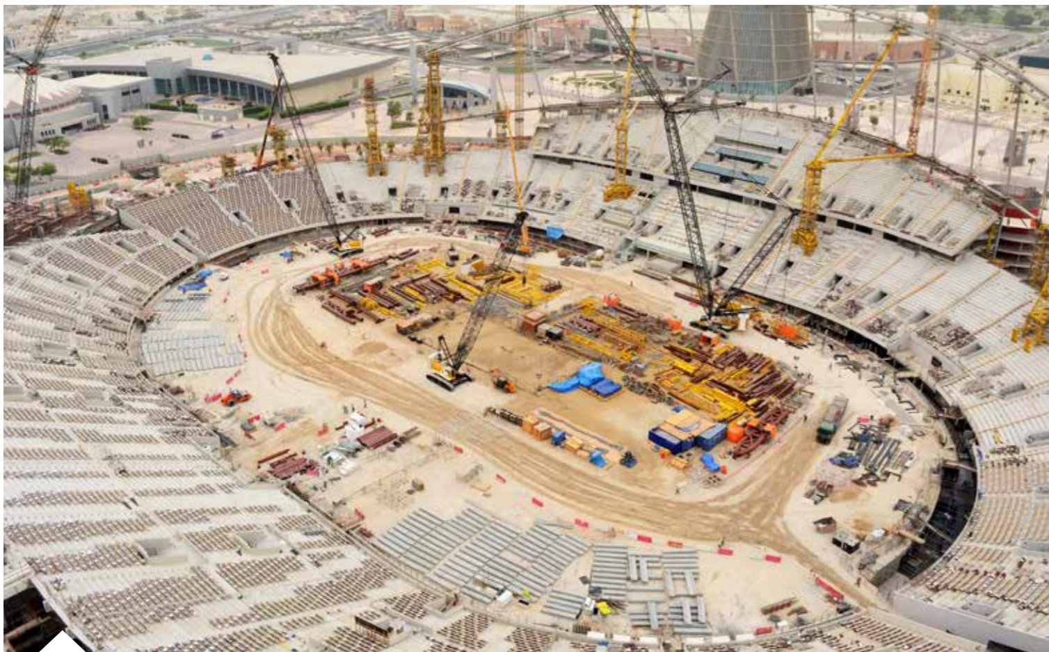
■ El Khalifa Stadium se está renovando y ampliando para el Campeonato Mundial de Atletismo en 2019 y el Mundial de Fútbol en 2022. En este proyecto trabajan varias grúas con orugas de la flota Aertssen
